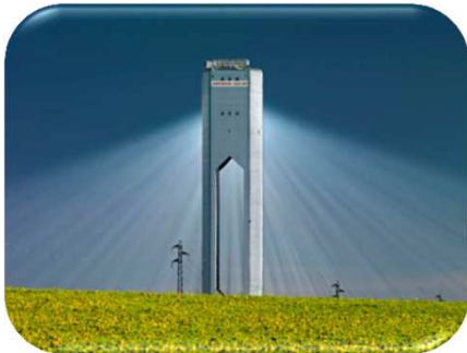
20 MW CSP Torre (España)
